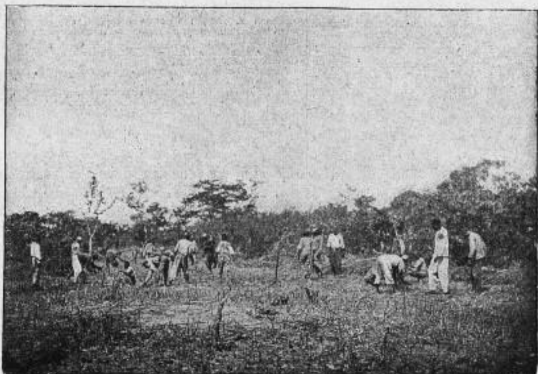
Ouverture à la hache de la route Congo-Nil, les gros arbres sautent par la mélérite. — Une équipe en action : la section des hacheurs.
