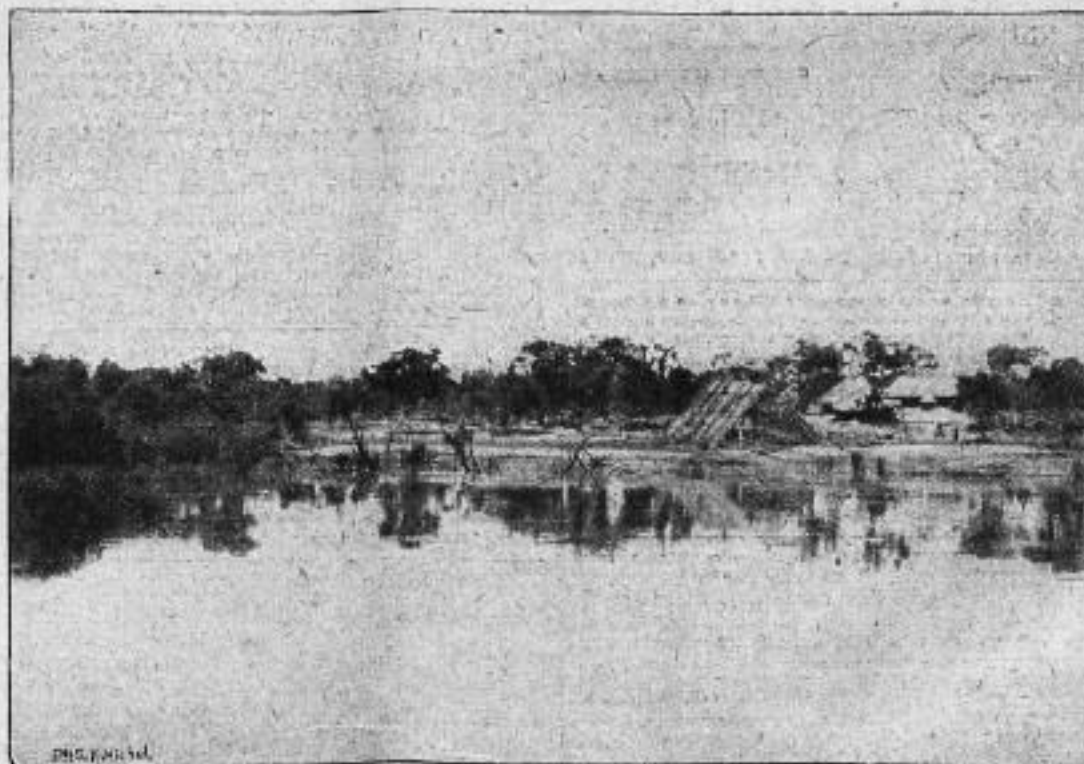
Le « Soueh » et la partie Sud du poste arsenal du Kodjalé, extrémité Sud-Ouest, par le Ghazal, de la navigation sur les eaux nilotiques. — A gauche, on voit le hangar-radoub en construction pour le remontage des vapeurs et chalands démontés au port de la Méré.
