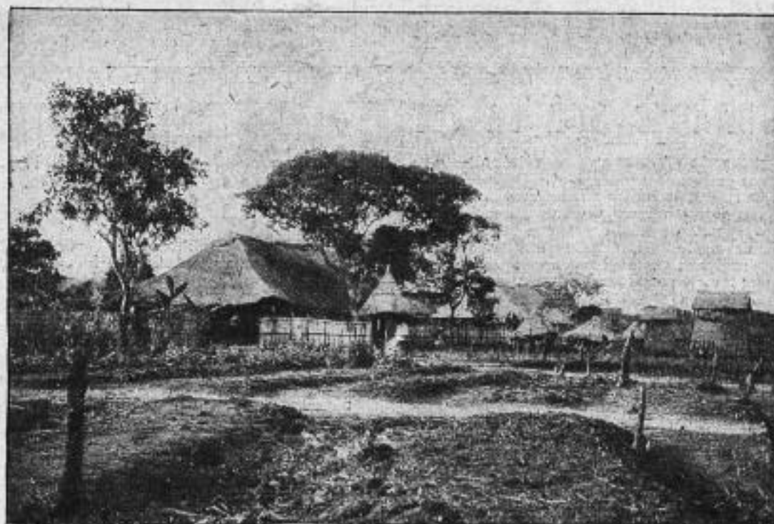
Un grand poste de centralisation
